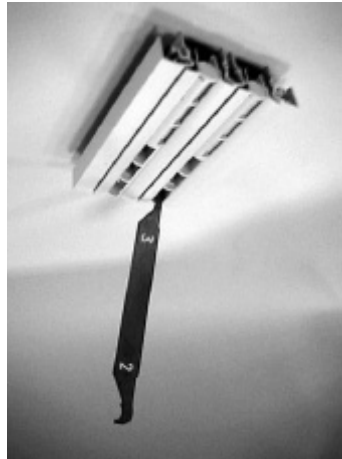
Walzenstellung 2 oder 3 einstellen: Den Verstellschlüssel wie gezeigt ansetzen, dabei das entsprechend gekennzeichnete Ende benutzen.
