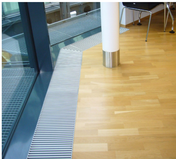
Einbaubeispiel, mit LTG Aluminium-Rollrost
