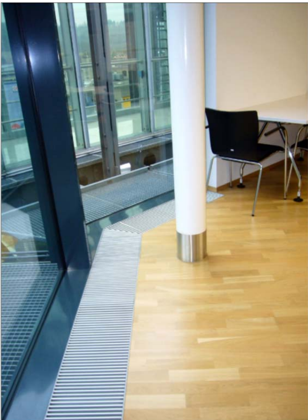
Einbaubeispiel, mit LTG Aluminium-Rollrost
